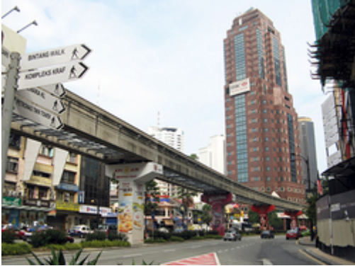
クアラルンプール市内モノレールの高架線。（筆者撮影）
