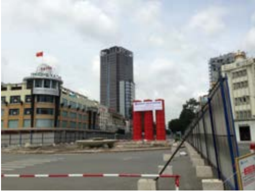
ホーチミンの中心部で突然始まった大規模な地下鉄工事
